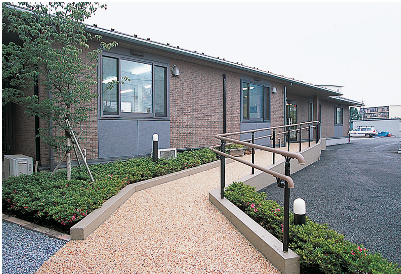
上部2段笠木(B型:上段・B型:下段) 納まり 埋込み式
