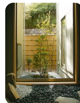
間柱式[ブロンズつや消し] 連続独立納まり 巾:2000×高:3000 建仁寺垣(上段:1200+900)十四ツ目垣(下段:900) [真竹]
