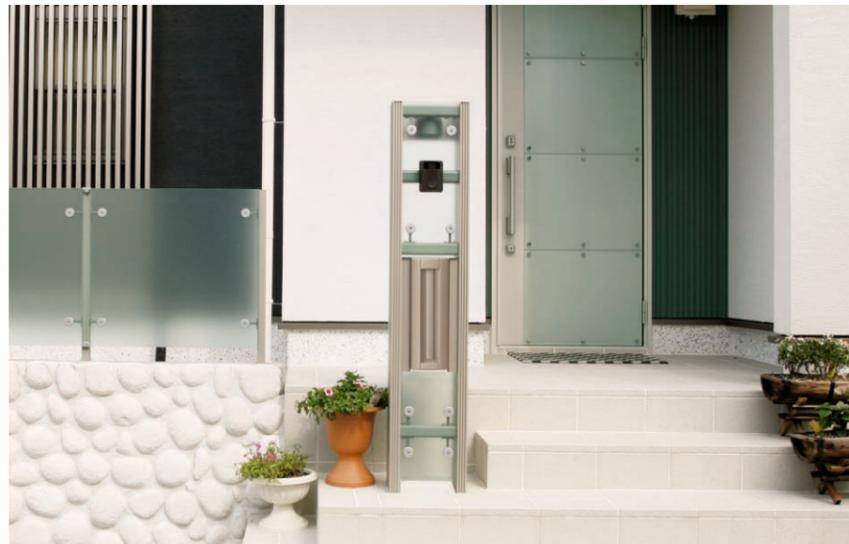
マット調のポリカーボネートパネルを、ドットポイントで取り付けました。モダンなイメージに良く合う、シャープでクリアなデザインです。
